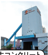
生コンクリート
